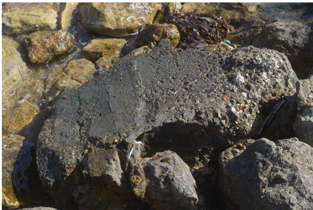
A.M.G. 007. Vestigis dels taulons de l'encofrat. Casamata Marineta Cassiana-Rota d'Escolano.
